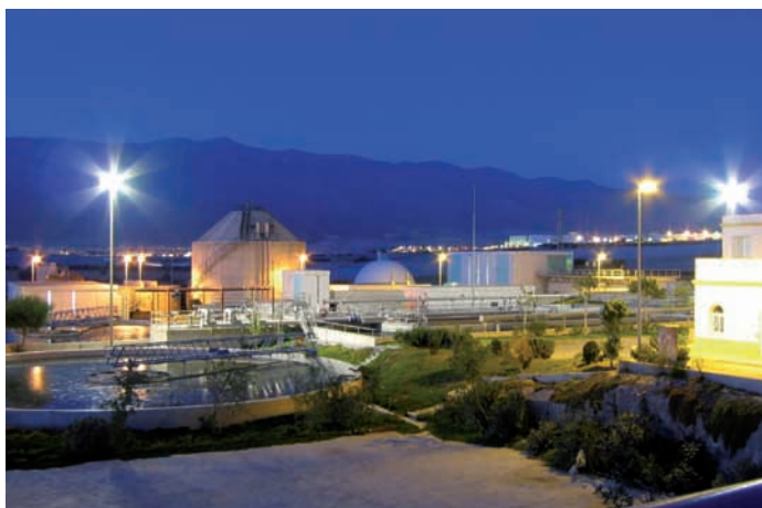
Vista nocturna de la Edar de El Ejido (Almería).
